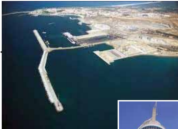
PSA Terminais de Contentores de Sines
